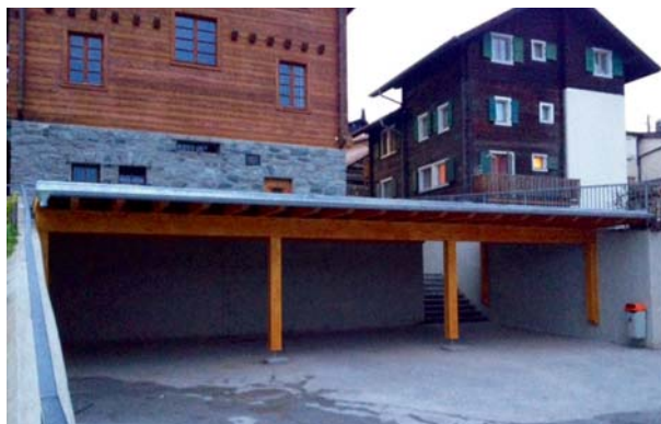
Un nouveau couvert en bois offre un large espace abrité sur la cour d'école.
