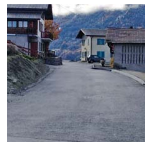
Chantier en cours sur la RC578.
