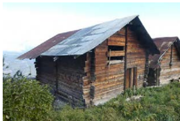
Façades sud-ouest et sud-est
