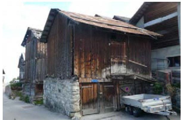
Façades nord-ouest et sud-ouest
