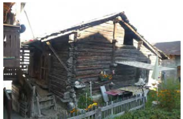
Façades sud-ouest et sud-est
