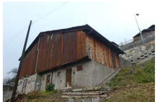
Façades nord-ouest et sud-ouest
