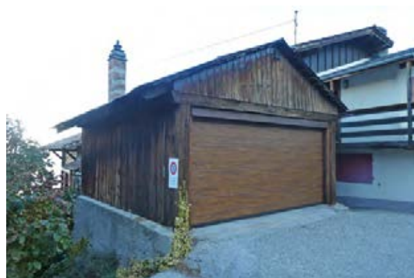
Façades sud-ouest et sud-est
