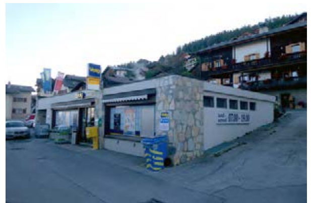
Façades nord-ouest et sud-ouest
