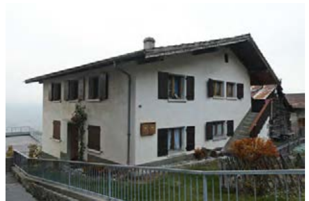
Façades sud-ouest et sud-est
