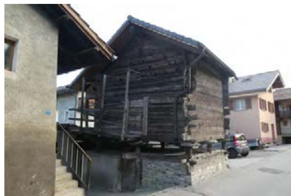
Façades sud-ouest et sud-est
