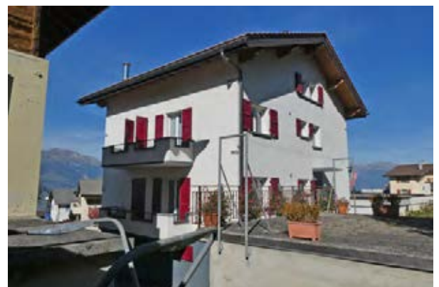
Façades sud-ouest et sud-est
