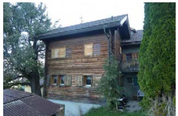
Façades sud-ouest et sud-est
