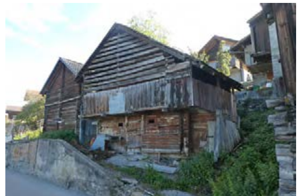
Façades nord-ouest et sud-ouest
