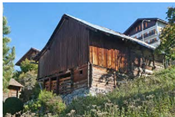
Façades nord-ouest et sud-ouest
