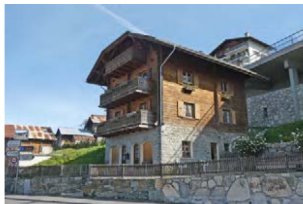
Façades nord-ouest et sud-ouest
