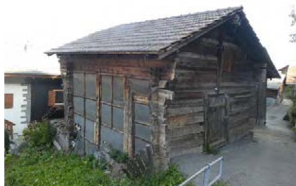
Façades sud-ouest et sud-est
