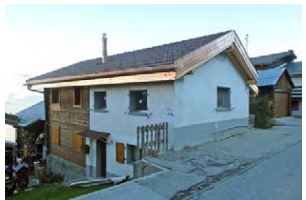
Façades sud-ouest et sud-est
