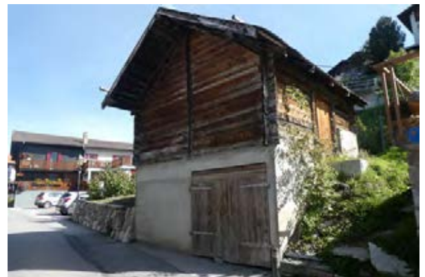
Façades nord-ouest et sud-ouest
