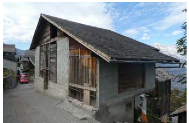
Façades sud-est et nord-est
