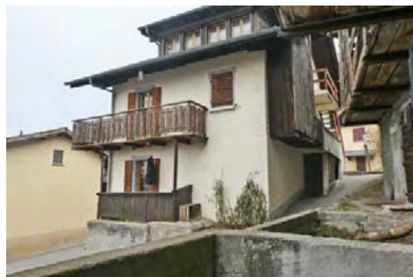
Façades sud-ouest et sud-est
