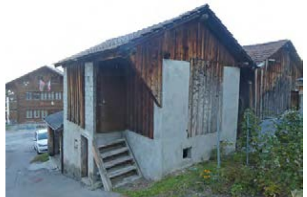
Façades sud-ouest et sud-est
