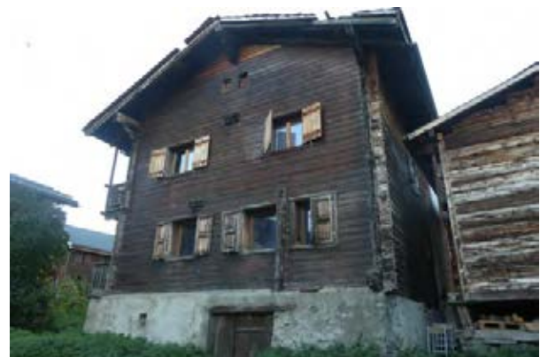
Façades nord-ouest et sud-ouest
