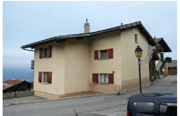
Façades sud-ouest et sud-est
