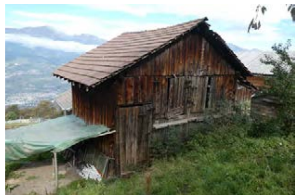
Façades sud-ouest et sud-est
