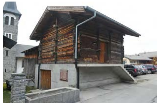
Façades sud-ouest et sud-est
