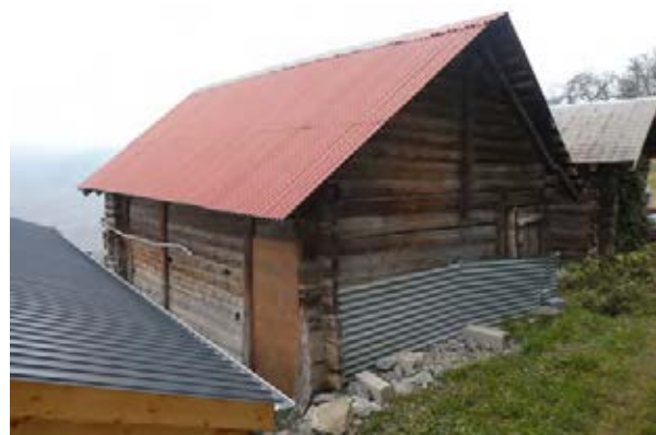
Façades sud-ouest et sud-est
