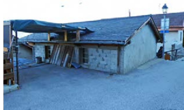
Façades sud-ouest et sud-est
