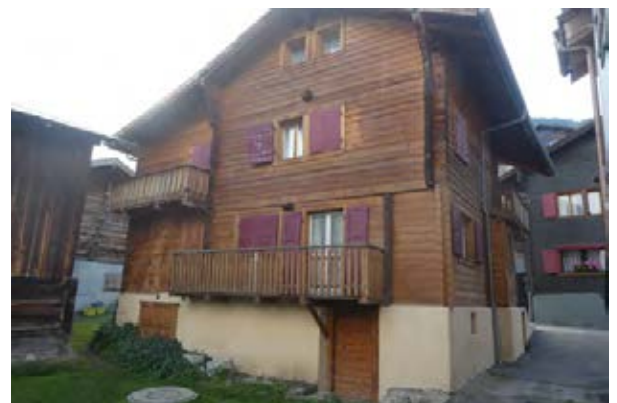
Façades nord-ouest et sud-ouest
