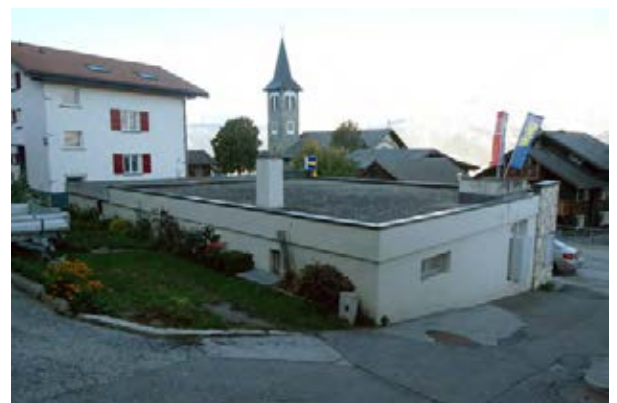
Façades sud-est et nord-est
