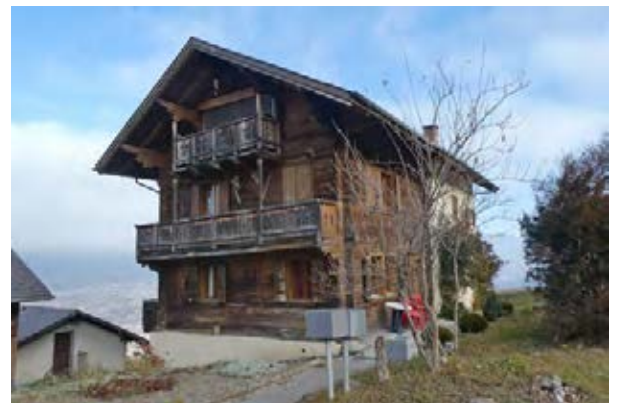
Façades sud-ouest et sud-est
