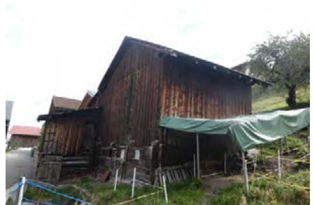
Façades nord-ouest et sud-ouest
