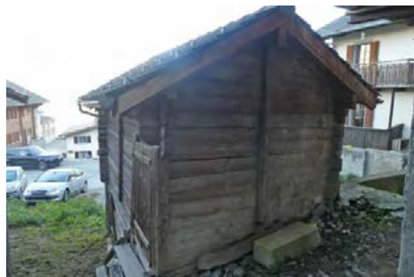
Façades sud-ouest et sud-est
