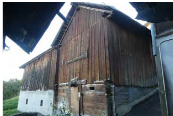
Façades nord-ouest et sud-ouest
