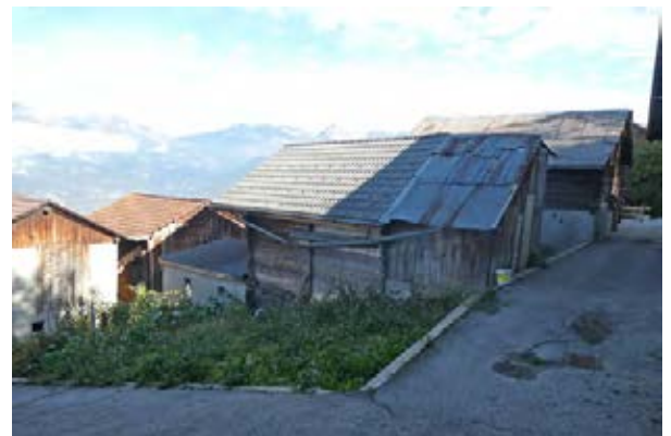
Façades sud-ouest et sud-est
