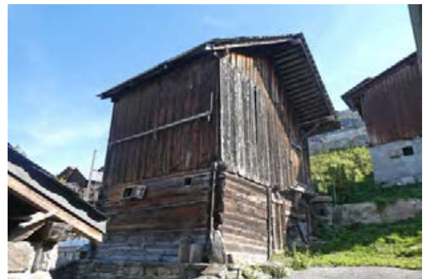
Façades nord-ouest et sud-ouest
