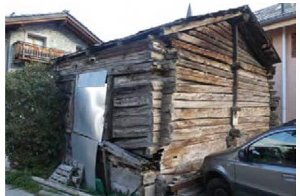
Façades sud-ouest et sud-est
