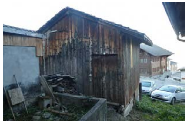
Façades sud-est et nord-est
