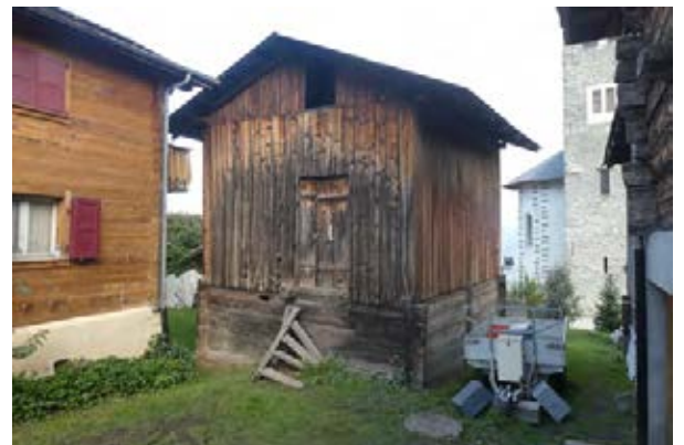
Façades sud-est et nord-est
