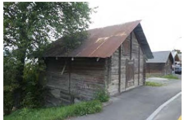
Façades sud-ouest et sud-est
