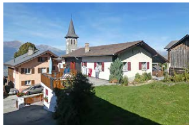
Façades sud-ouest et sud-est
