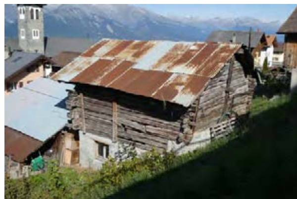
Façades sud-ouest et sud-est
