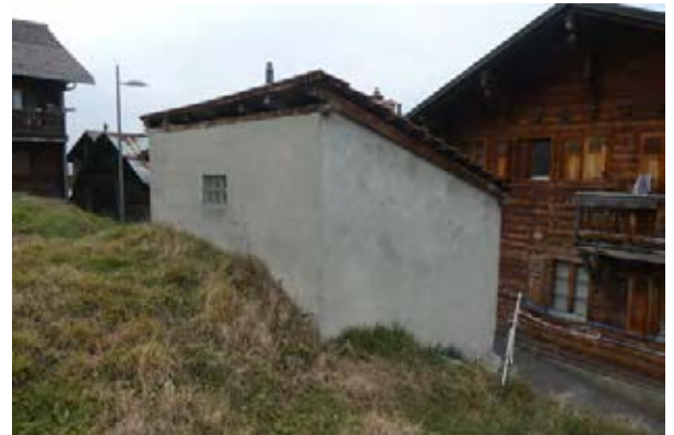
Façades sud-est et nord-est
