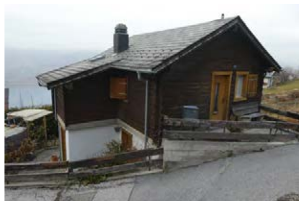
Façades sud-ouest et sud-est
