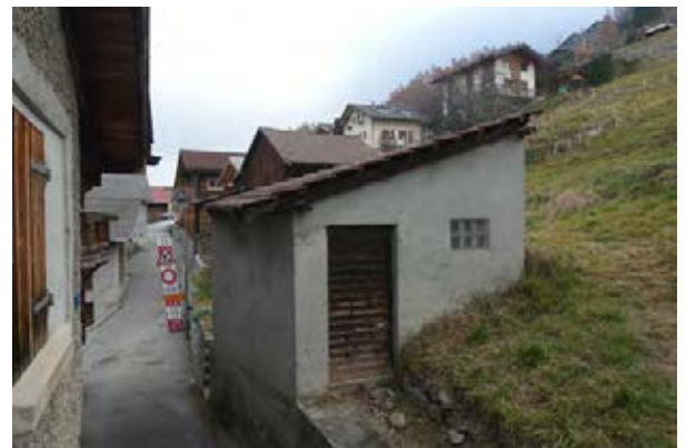
Façades nord-ouest et sud-ouest
