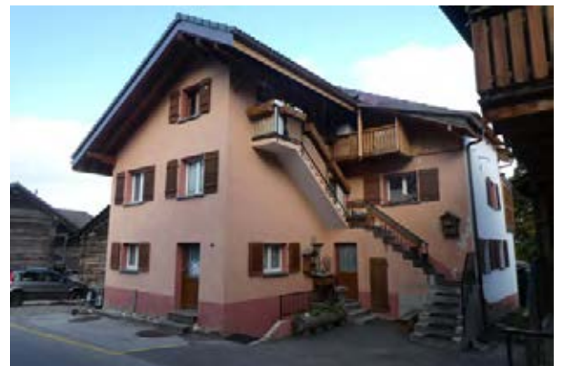
Façades sud-est et nord-est
