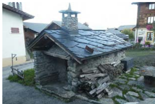
Façades sud-ouest et sud-est
