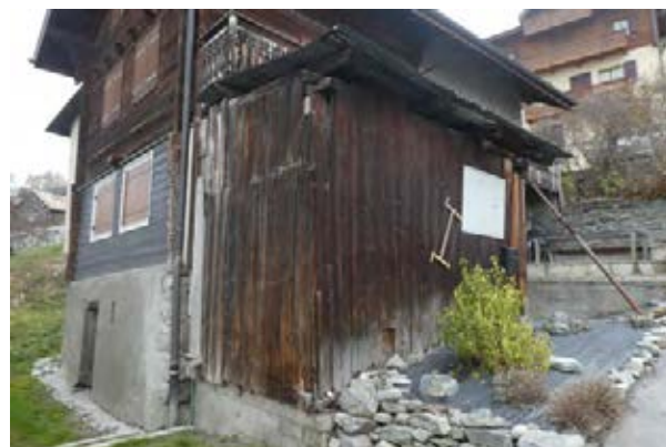
Façades nord-ouest et sud-ouest
