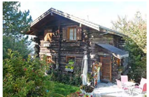
Façades sud-est et nord-est
