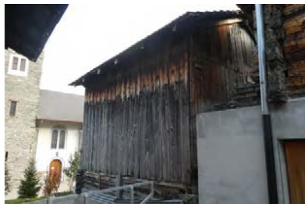
Façades sud-ouest et sud-est
