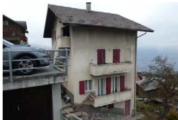
Façades sud-est et nord-est
