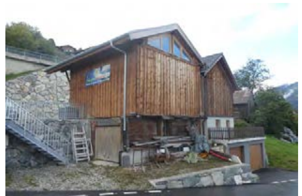
Façades nord-est et nord-est
