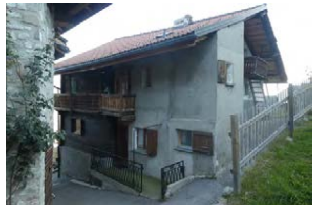
Façades sud-ouest et sud-est
