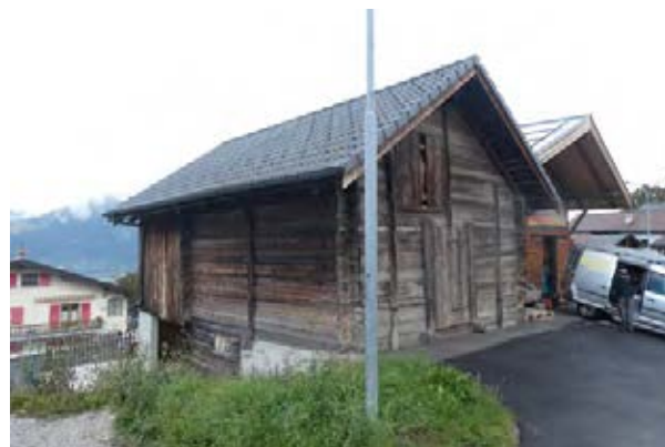
Façades sud-ouest et sud-est
