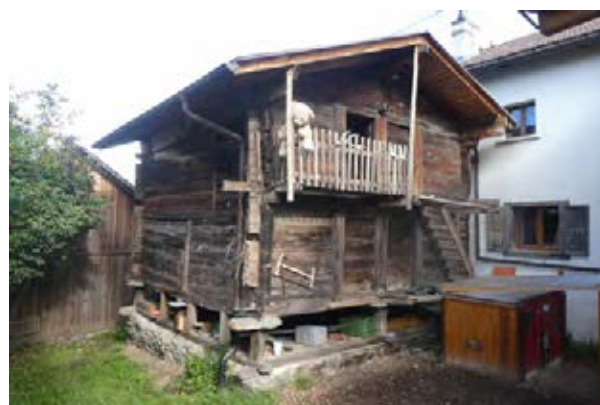
Façades sud-ouest et sud-est
