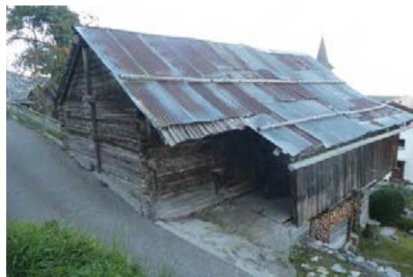
Façades sud-est et nord-est
