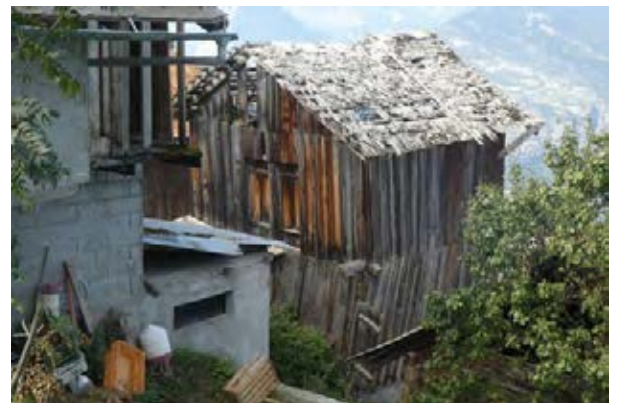
Façades sud-est et nord-est
