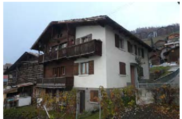
Façades nord-ouest et sud-ouest
