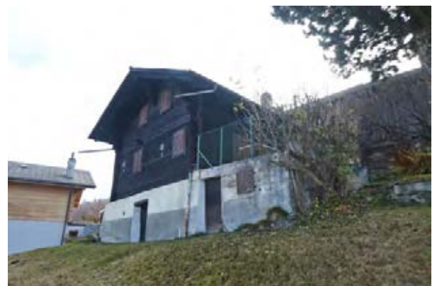
Façades nord-ouest et sud-ouest
