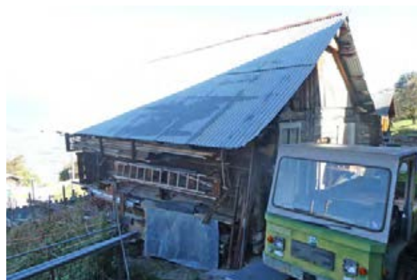
Façades sud-ouest et sud-est
