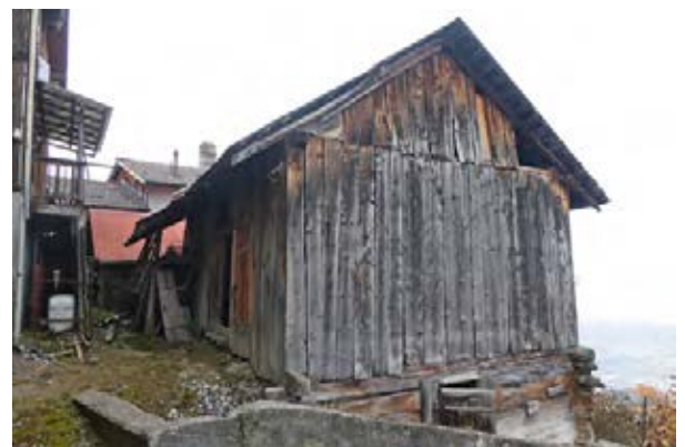
Façades sud-est et nord-est
