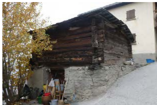
Façades sud-ouest et sud-est
