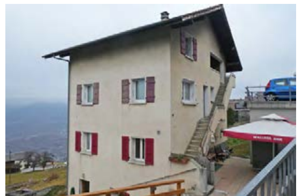
Façades sud-ouest et sud-est
