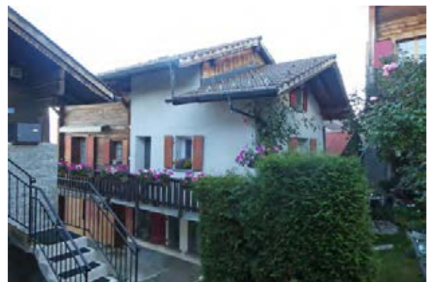
Façades sud-ouest et sud-est
