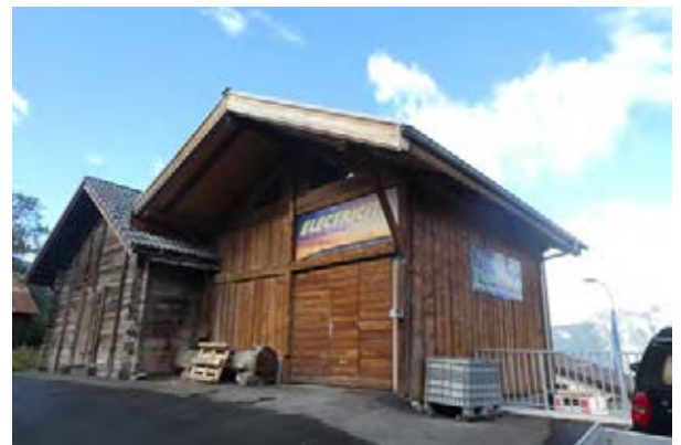
Façades sud-est et nord-est
