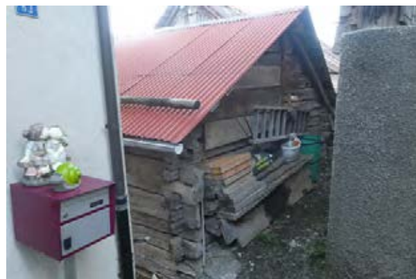
Façades sud-ouest et sud-est
