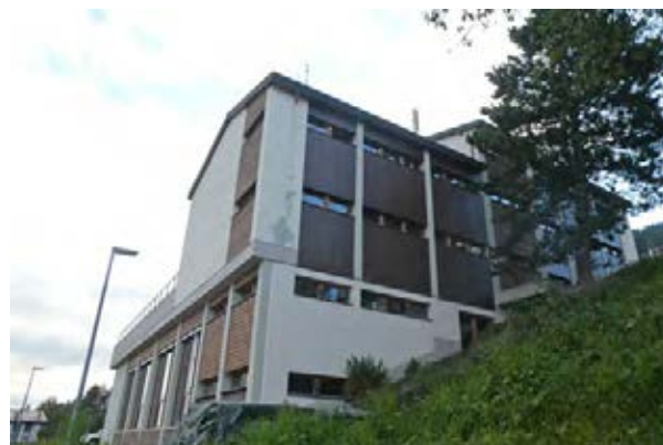
Façades nord-ouest et sud-ouest
