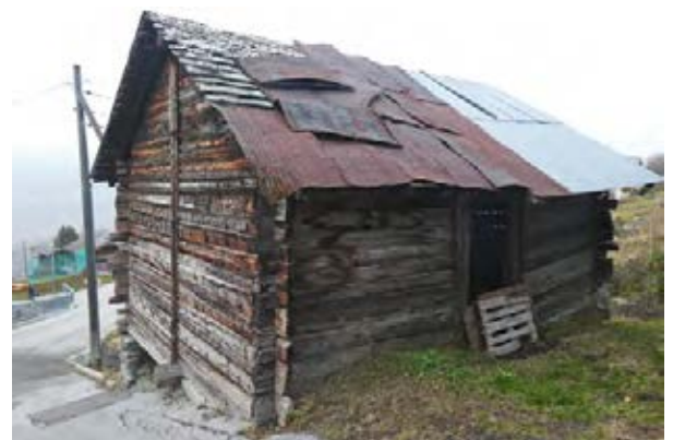
Façades sud-ouest et sud-est
