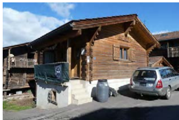
Façades sud-ouest et sud-est
