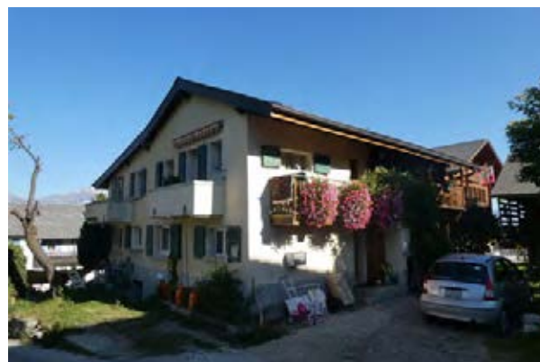
Façades sud-ouest et sud-est
