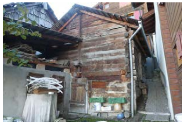
Façades nord-ouest et sud-ouest
