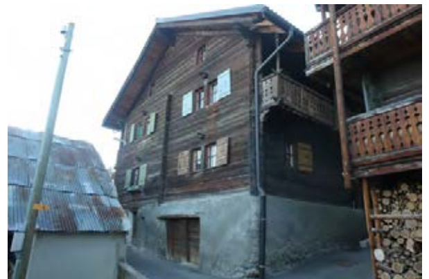
Façades nord-ouest et sud-ouest
