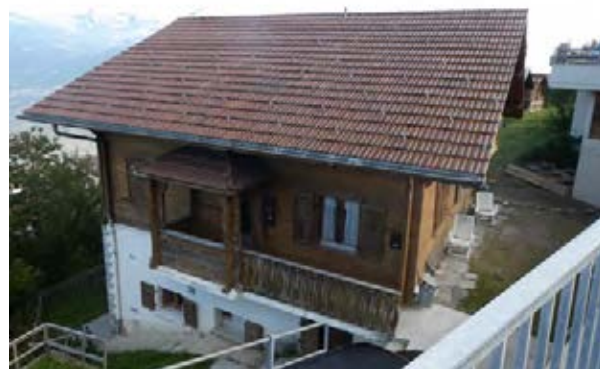
Façades sud-ouest et sud-est
