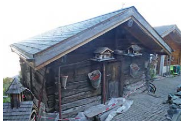
Façades sud-ouest et sud-est
