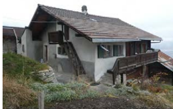
Façades sud-est et nord-est
