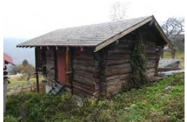
Façades sud-ouest et sud-est
