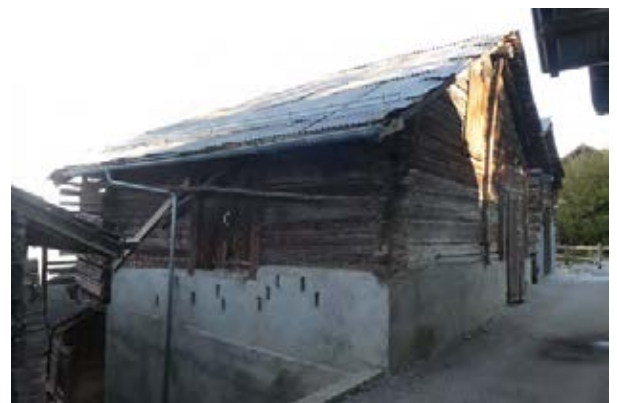
Façades sud-ouest et sud-est
