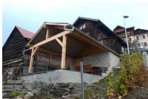
Façades nord-ouest et sud-ouest
