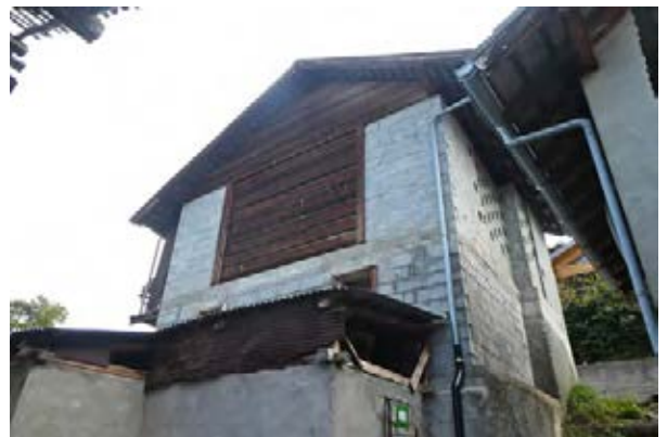
Façades nord-ouest et sud-ouest
