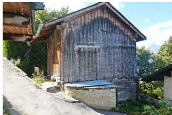
Façades sud-est et nord-est
