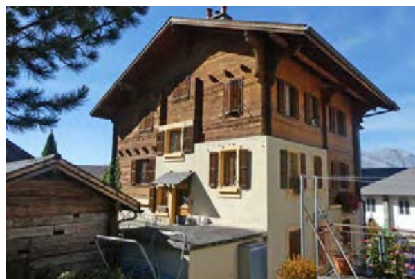
Façades sud-est et nord-est
