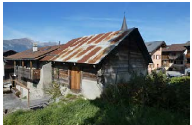
Façades sud-ouest et sud-est
