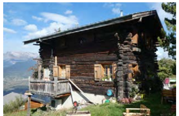
Façades sud-ouest et sud-est
