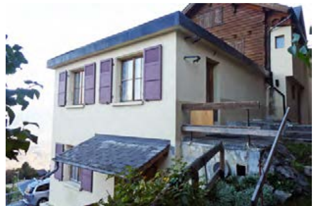
Façades sud-ouest et sud-est
