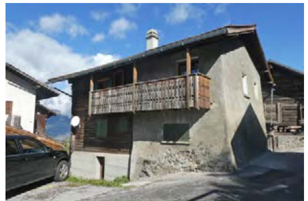
Façades sud-ouest et sud-est
