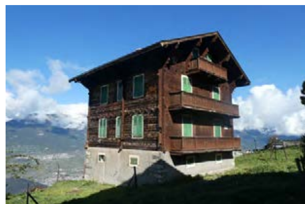
Façades sud-ouest et sud-est
