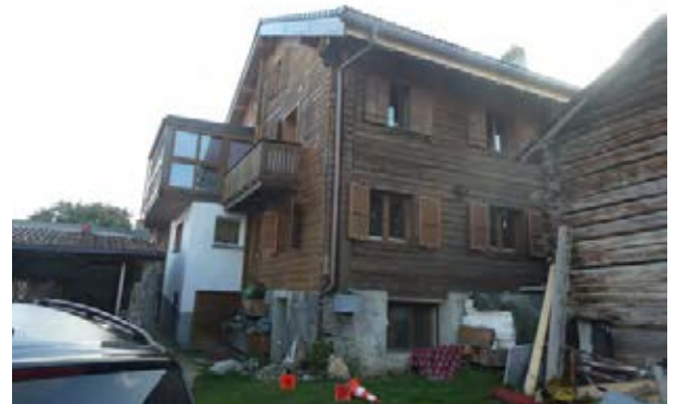
Façades nord-ouest et sud-ouest
