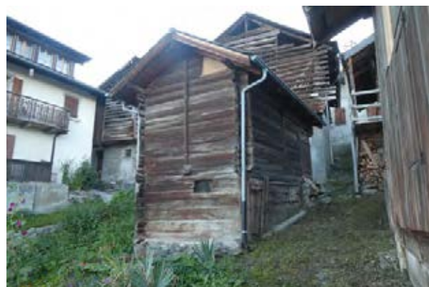
Façades nord-ouest et sud-ouest
