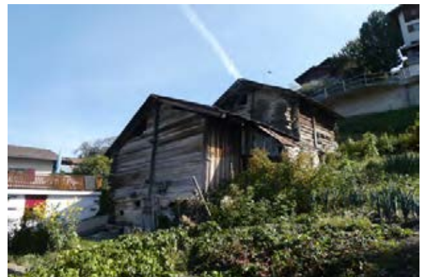
Façades nord-ouest et sud-ouest
