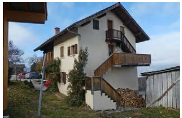
Façades sud-est et nord-est
