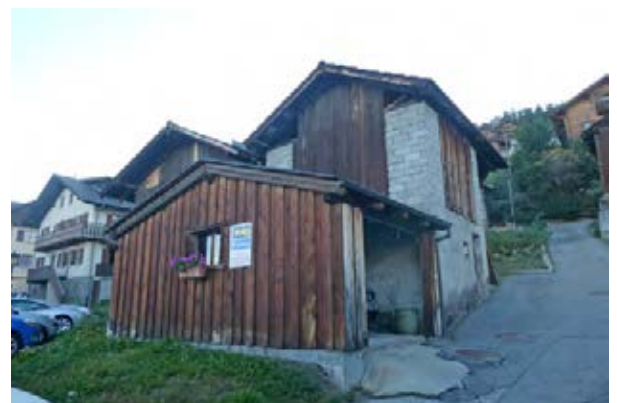
Façades nord-ouest et sud-ouest
