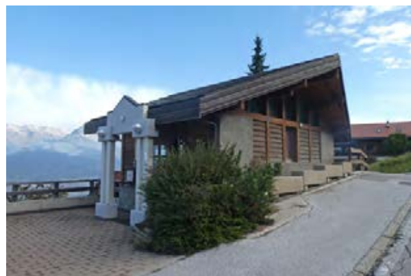
Façades sud-ouest et sud-est
