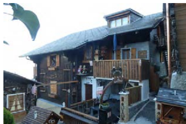
Façades sud-ouest et sud-est
