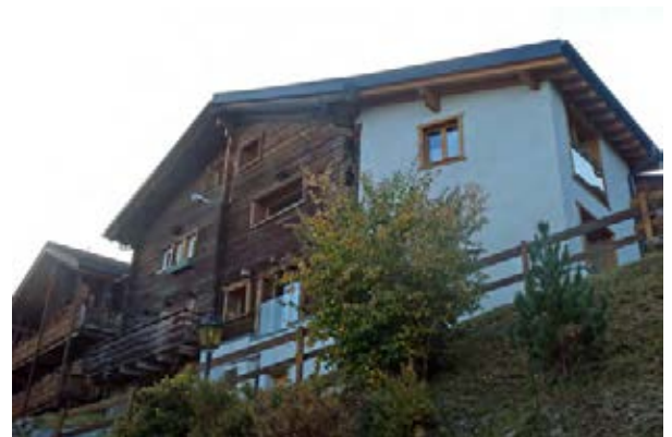
Façades nord-ouest et sud-ouest
