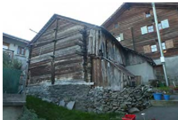
Façades nord-ouest et sud-ouest
