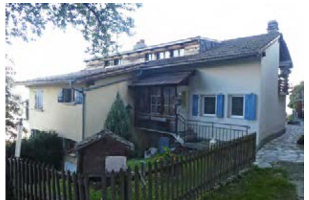
Façades sud-ouest et sud-est
