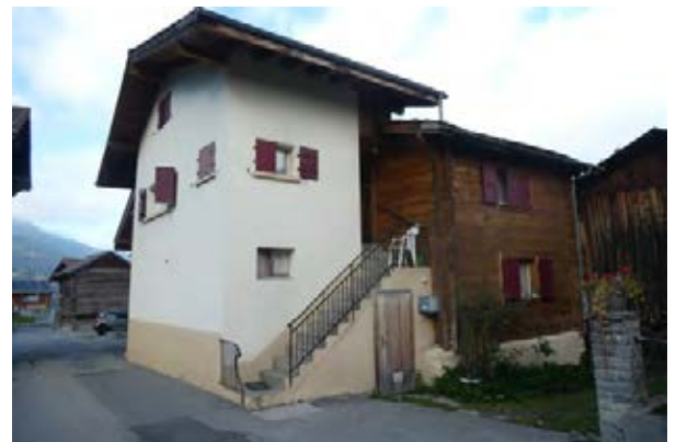
Façades sud-est et nord-est
