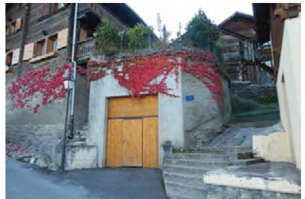
Façades nord-ouest et sud-ouest
