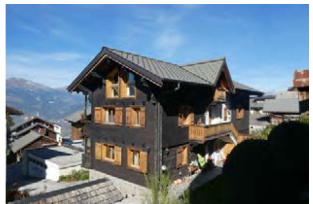
Façades sud-ouest et sud-est
