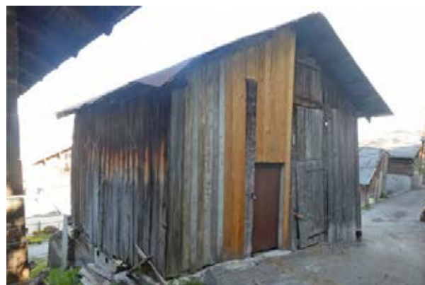
Façades sud-ouest et sud-est
