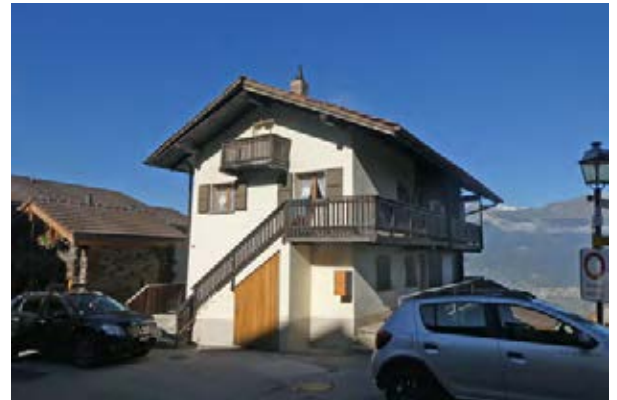
Façades sud-est et nord-est
