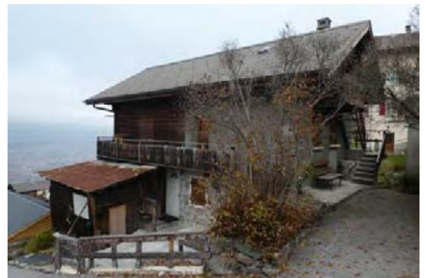
Façades sud-ouest et sud-est
