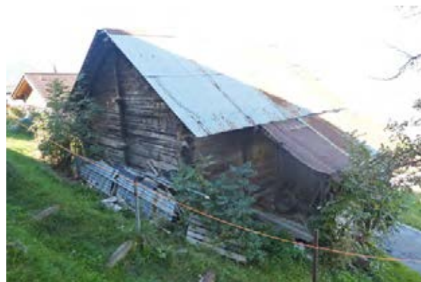
Façades sud-est et nord-est
