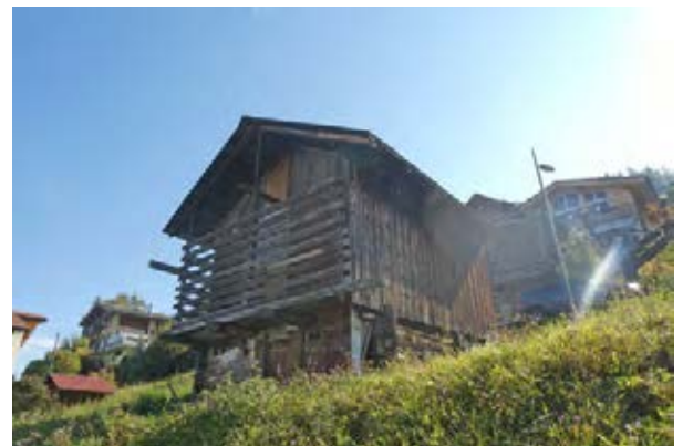
Façades nord-ouest et sud-ouest
