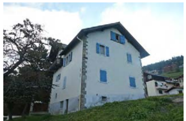
Façades nord-ouest et sud-ouest
