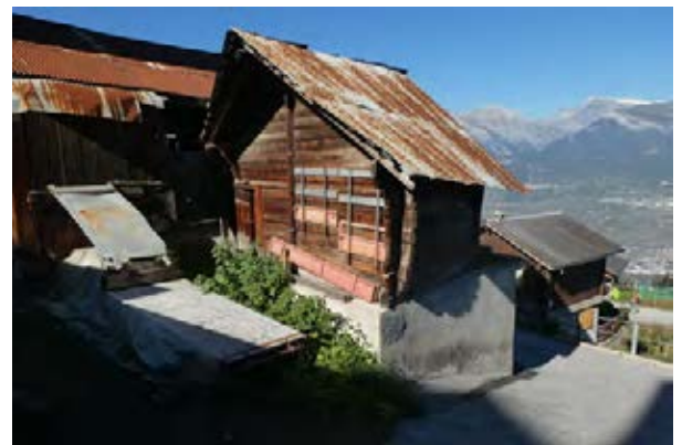
Façades sud-est et nord-est
