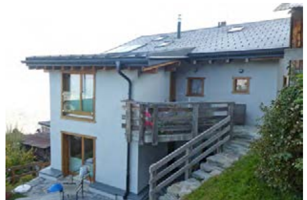
Façades sud-ouest et sud-est
