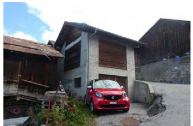
Façades nord-ouest et sud-ouest
