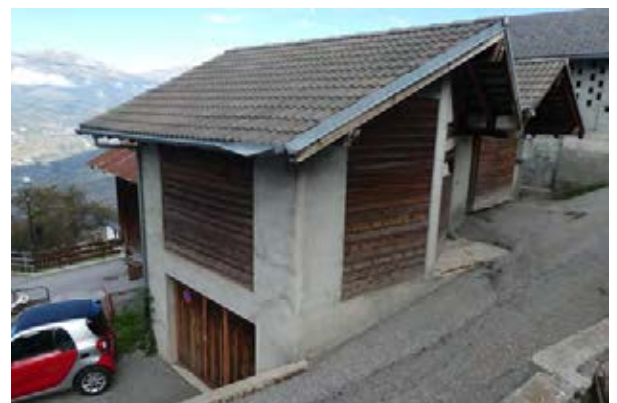
Façades sud-ouest et sud-est
