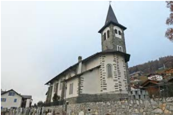
Façades nord-ouest et sud-ouest
