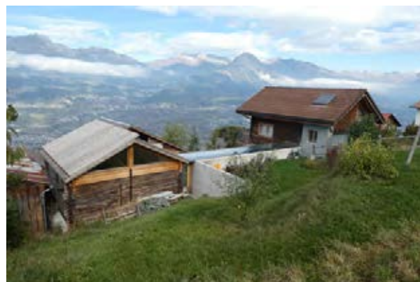
Façades sud-ouest et sud-est
