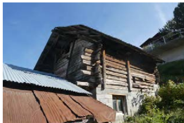
Façades nord-ouest et sud-ouest
