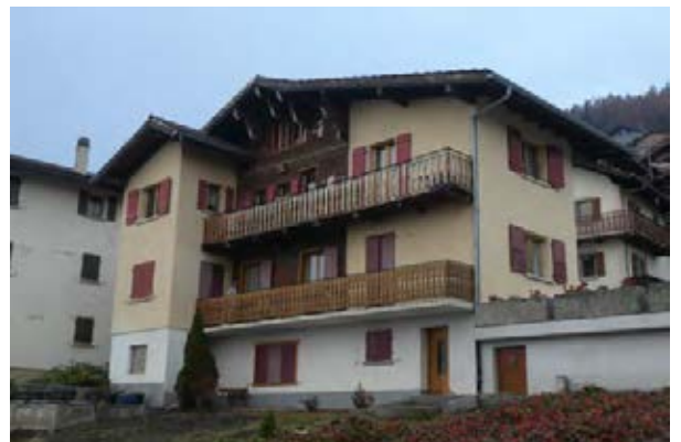
Façades nord-ouest et sud-ouest
