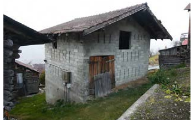
Façades sud-ouest et sud-est
