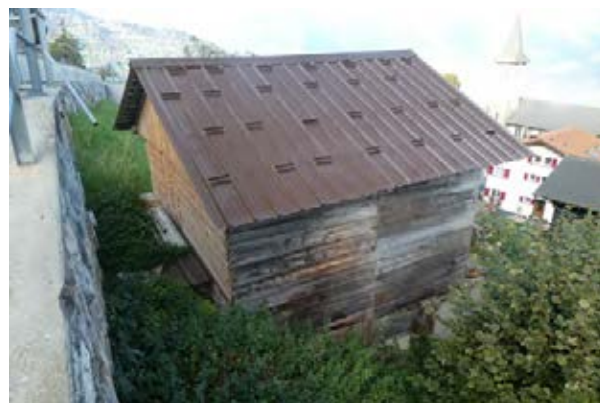
Façades sud-est et nord-est
