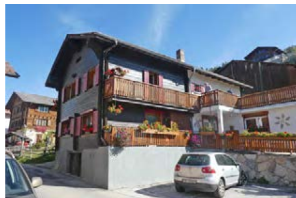
Façades nord-ouest et sud-ouest
