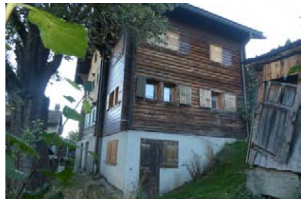
Façades nord-ouest et sud-ouest
