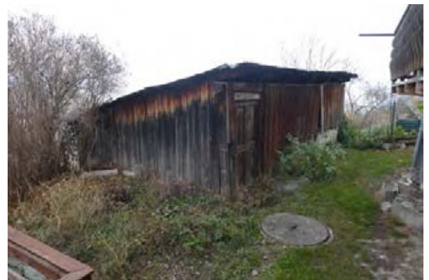
Façades sud-ouest et sud-est
