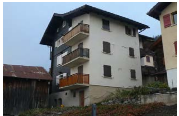
Façades nord-ouest et sud-ouest
