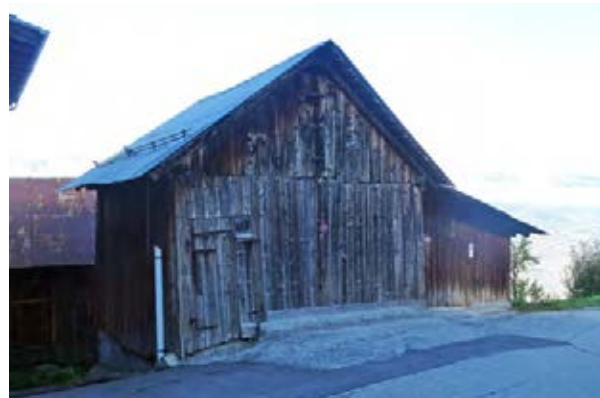
Façades sud-ouest et sud-est
