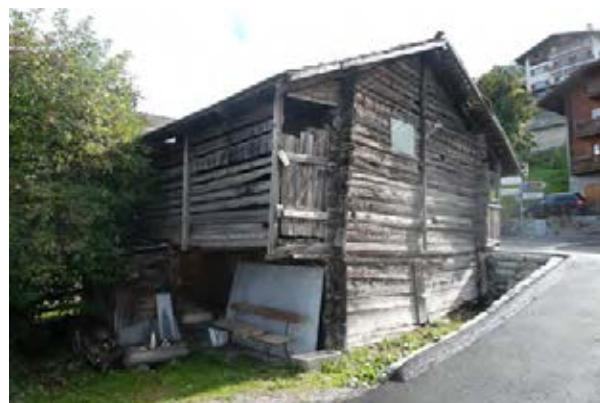
Façades nord-ouest et sud-ouest
