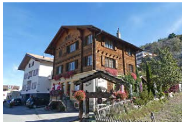
Façades nord-ouest et sud-ouest
