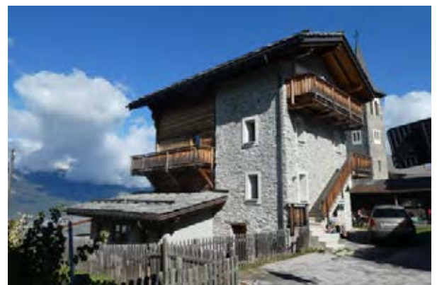
Façades sud-ouest et sud-est
