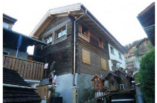
Façades nord-ouest et sud-ouest
