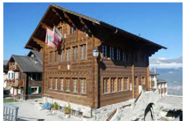
Façades sud-est et nord-est
