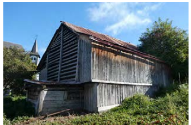
Façades nord-ouest et sud-ouest
