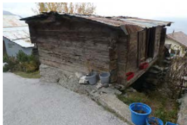
Façades sud-est et nord-est
