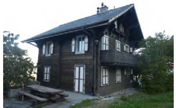
Façades sud-ouest et sud-est
