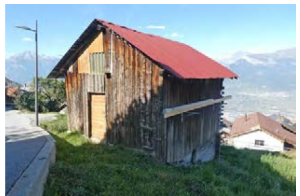
Façades sud-est et nord-est
