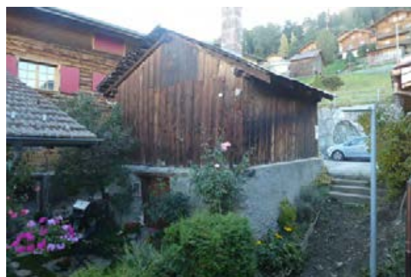
Façades nord-ouest et sud-ouest
