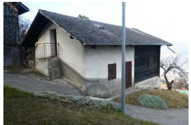
Façades sud-est et nord-est
