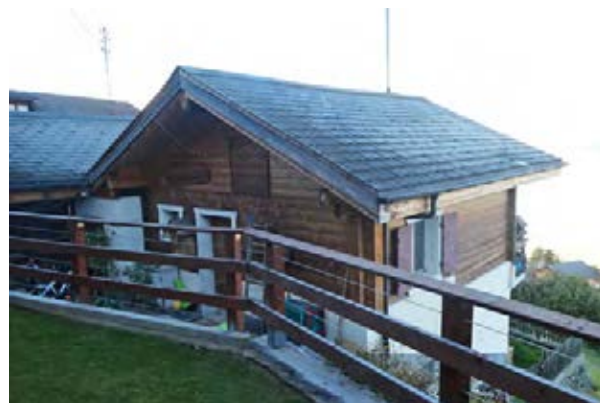
Façades sud-est et nord-est
