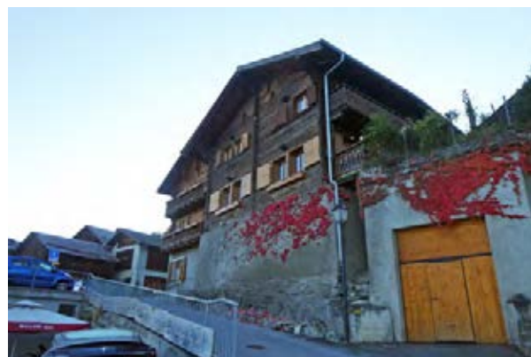
Façades nord-ouest et sud-ouest
