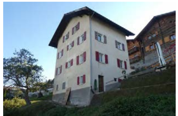
Façades nord-ouest et sud-ouest
