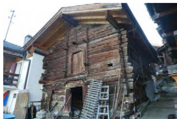
Façades nord-ouest et sud-ouest
