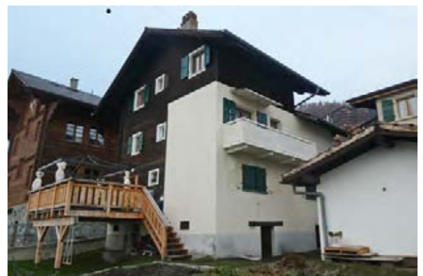
Façades nord-ouest et sud-ouest
