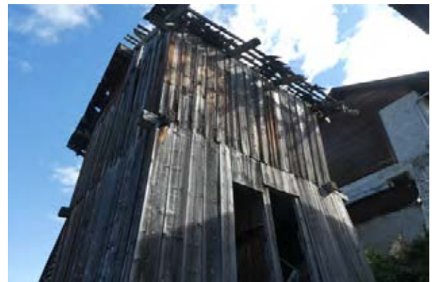
Façades nord-ouest et sud-ouest
